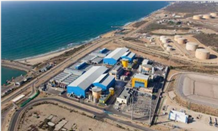
PARQUE DESALINIZADOR ISRAEL
