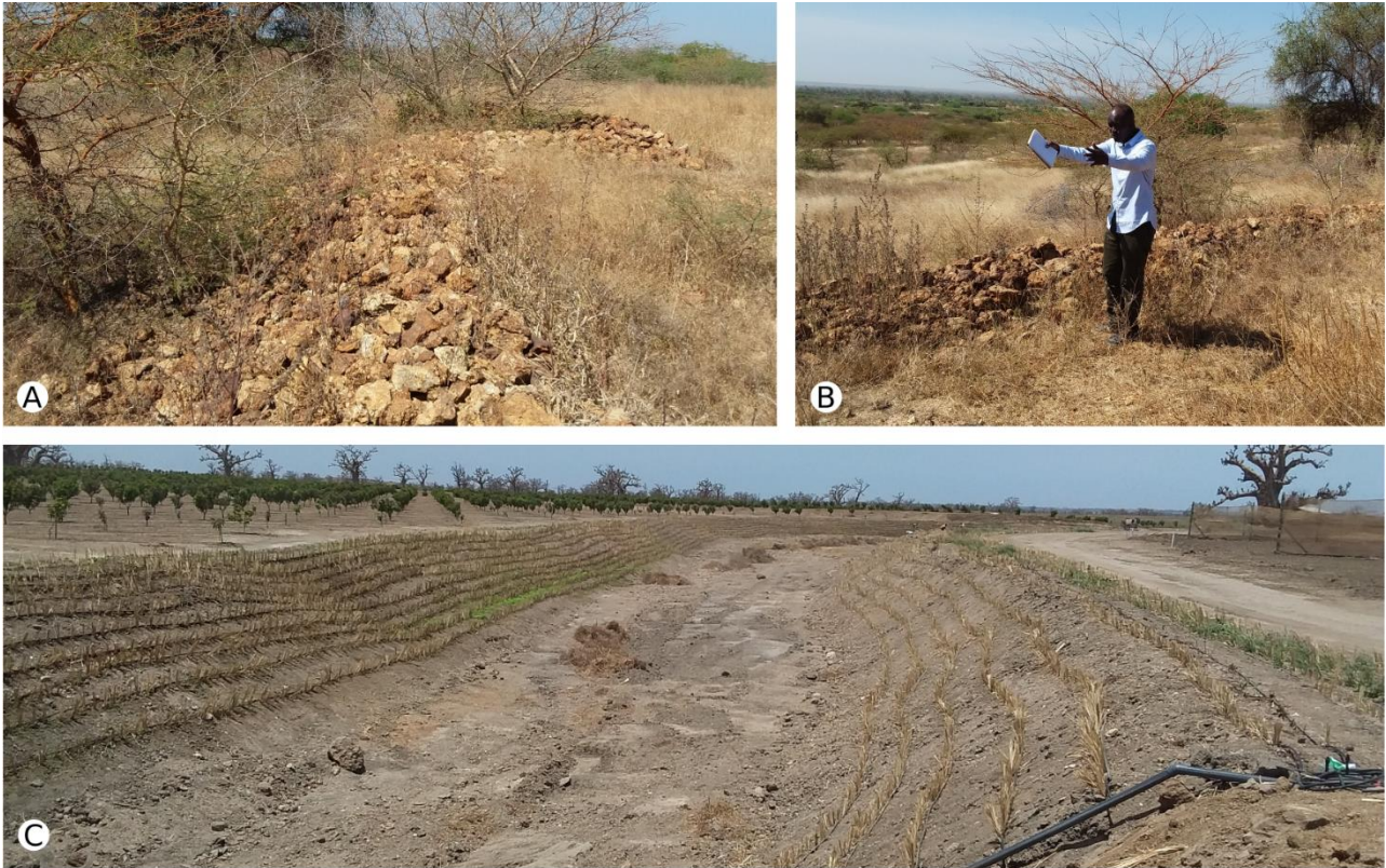
A et B: cordons pierreux; C: plantation de Vetiver irrigué sur berges;
