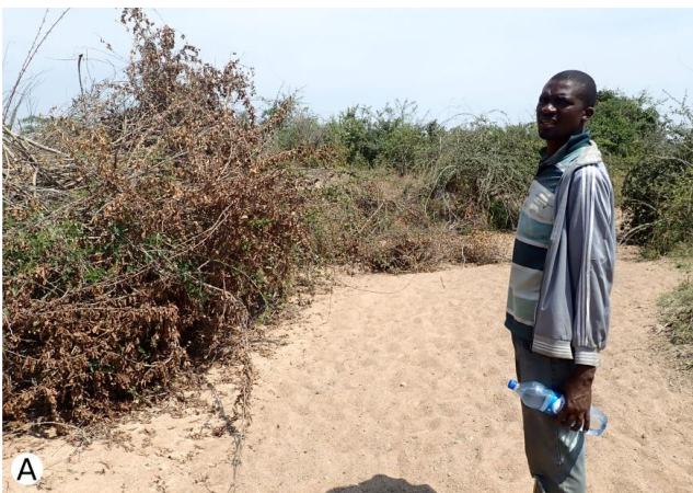
Figure 4-8. Stabilisation des berges par réalisation de 'peignes' de branchage (Tanzanie)
